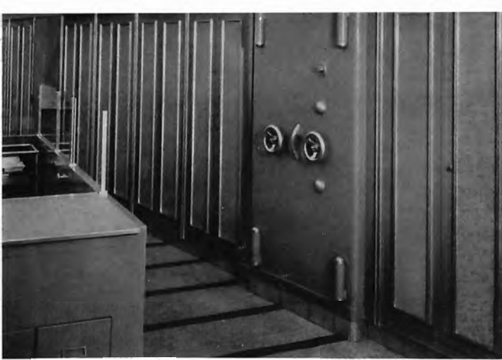
Stahlschrankwand mit Stahlpanzerkass in einem Geldinstitut Wall of steel cabinets with armoured safe in banking establishment Paroi d'armoires en acier, avec coffre-fort blindé, dans une banque
