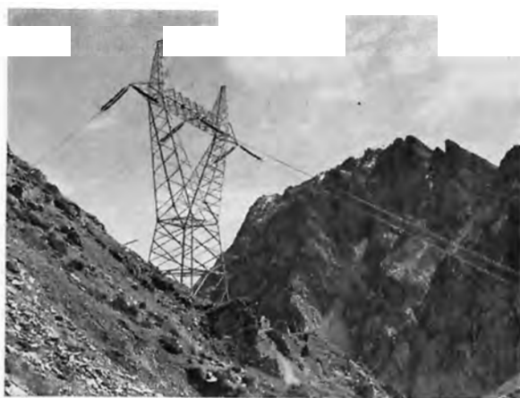
Bild 7: Abspannmast der 220-kV-Leitung Lienz—Pelos
