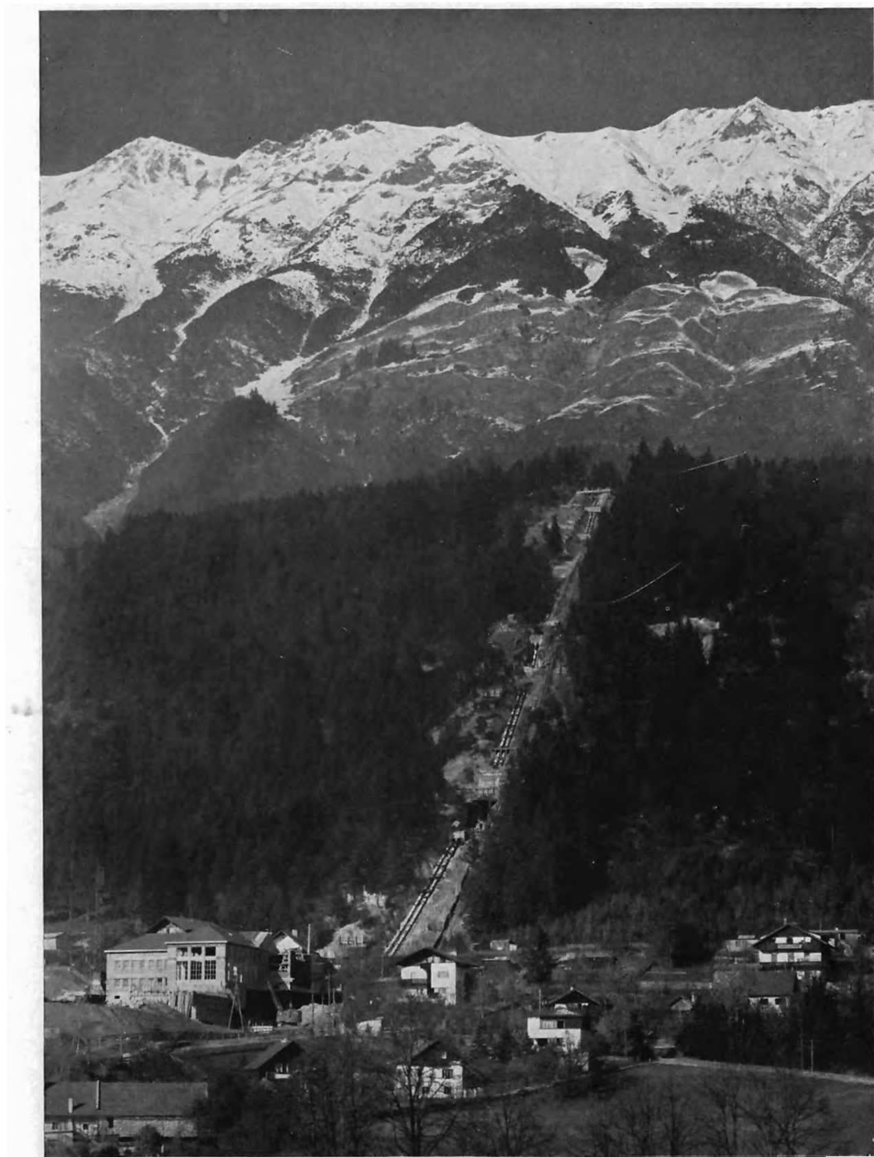
Druckrohrleitung des Kraftwerkes Mühlau, Innsbruck
