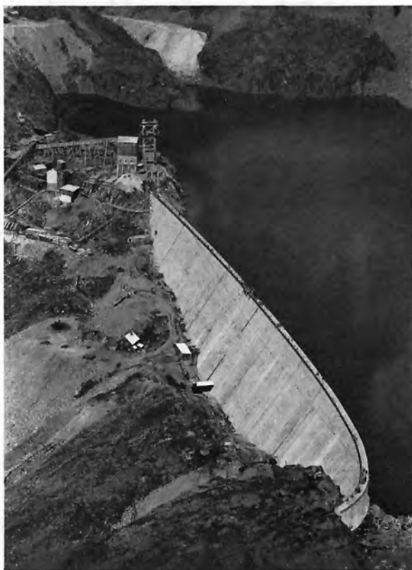
Bild 3: Winterspeicherwerk Reifheck-Kreuzeck, Staumauer „Großer Mühlbachersee“
