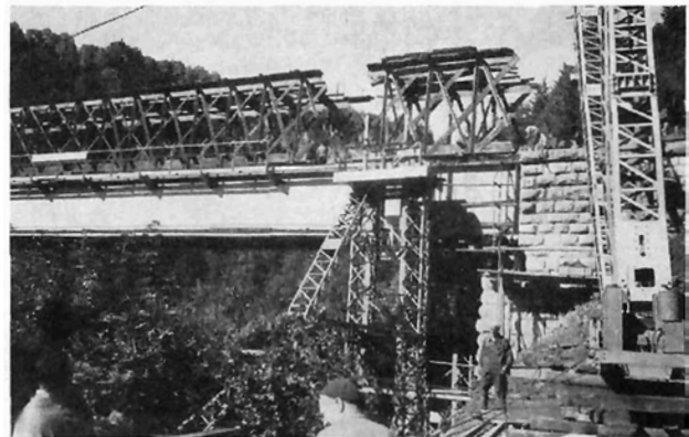
Bild 7a: Demontage des alten Tragwerkes
