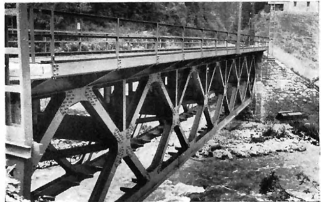
Bild 5b: Ansicht der neuen Brücke
