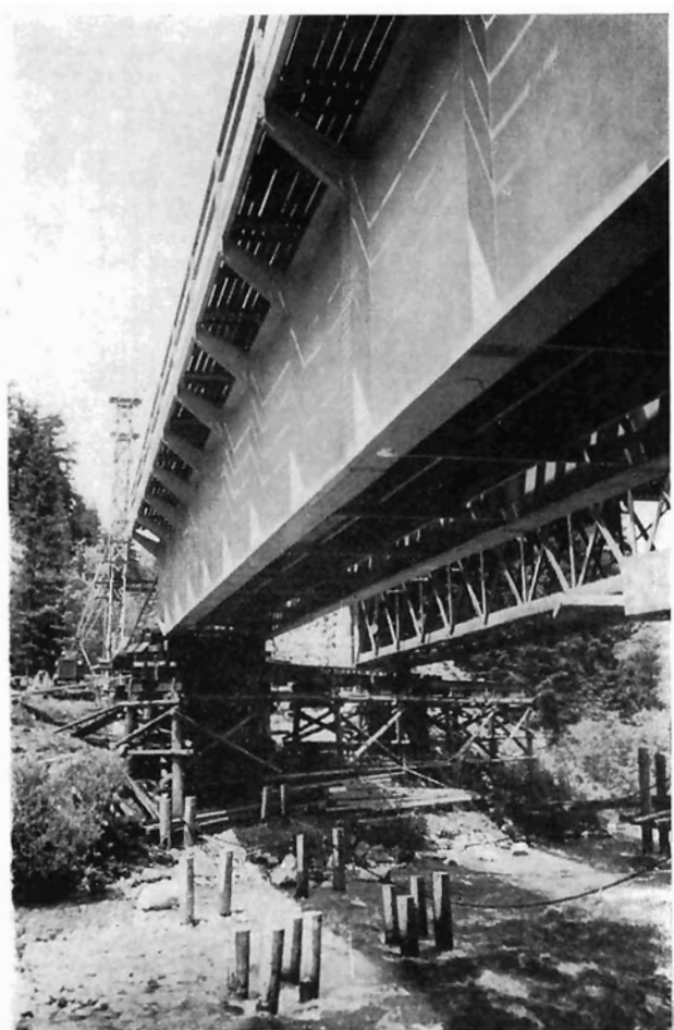
Bild 6b: Montagevorgang Fig. 6b: Erection
