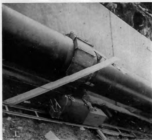
Bild 53: Spannungsfreiglühen einer Montage-Rundnaht einer freien Druckrohrleitung, elektrischer (nicht induktiver) Aufenglühofen. Druckrohrleitung Riddes (Anlage Mauvoisin, Walliser Alpen). Gebrüder Sulzer AG, Winterthur
