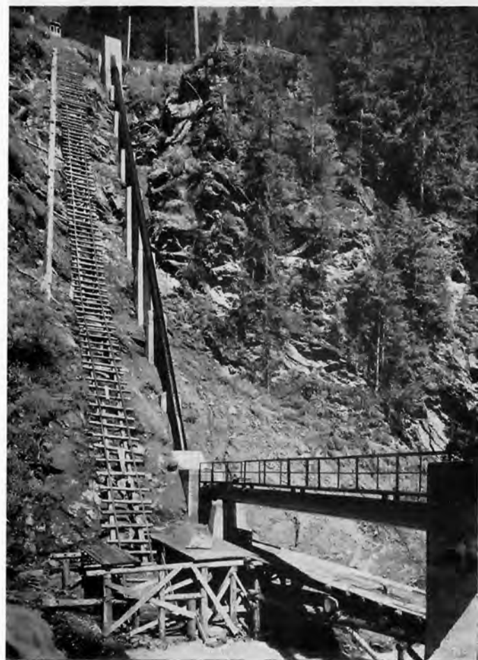
Bild 67: Steilstrecke der Druckrohrleitung des Kraftwerkes Debant II der TIWAG. Waagner-Biró AG, Wien-Graz. Vgl. auch Bild 20
