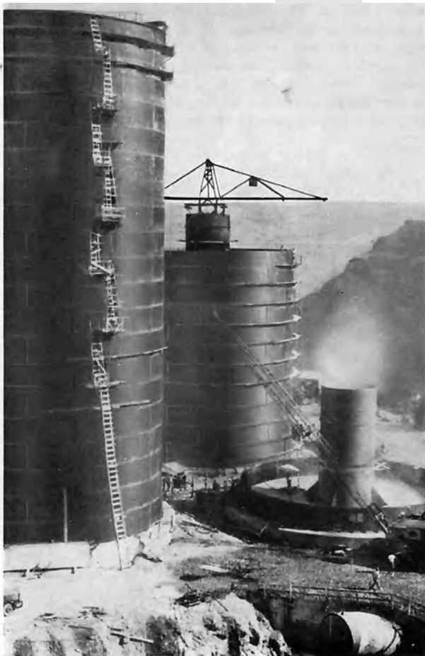
Bild 11: Montage der Wasserschloßbehälter für das Kraftwerk Seyhan
