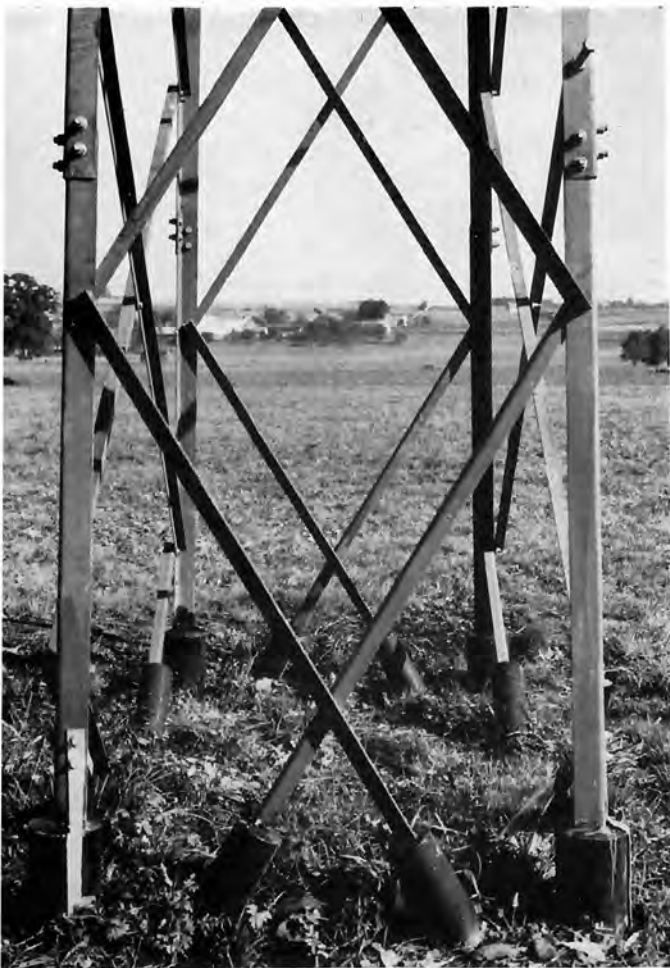
Bild 3: 110-kV-Leitung Ostermiething — Ach, Tragmastfundierung. VOEST, Linz
