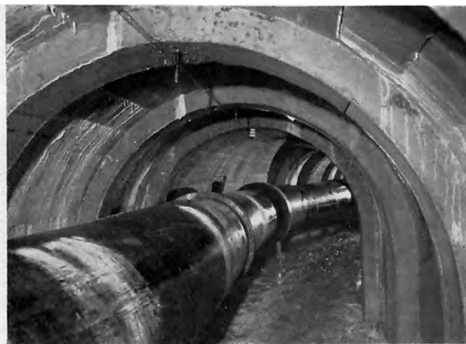
Bild 5: Im Rohrstollen verlegte freie Druckrohrleitung. Speicherstufe Reifheck der Österr. Draukraftwerke AG, Triebwasserweg vom Speicher zum Wasserschloß, Waagner-Biró AG, Wien-Graz
