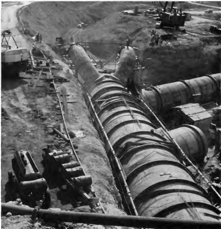
Bild 8: Druckprobe der Verteilleitung des Kraftwerkes Seyhan
