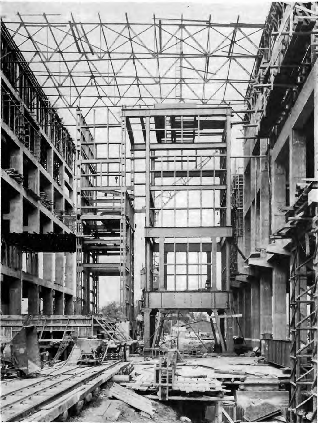
Bild 12: Kraftwerk St. Andrä, Kesselgerüst Wagner- Biró AG, Wien-Graz
