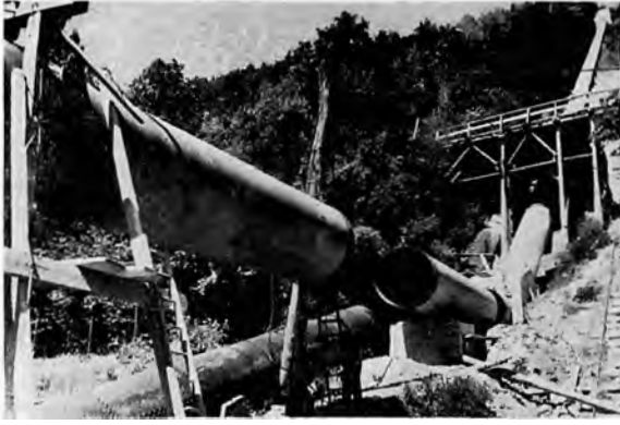
Bild 76: Druckrohrleitungsstrang II des Rannakraftwerkes der OKA; Montage. VÖEST-Linz. Links der alte, genietete Strang I
