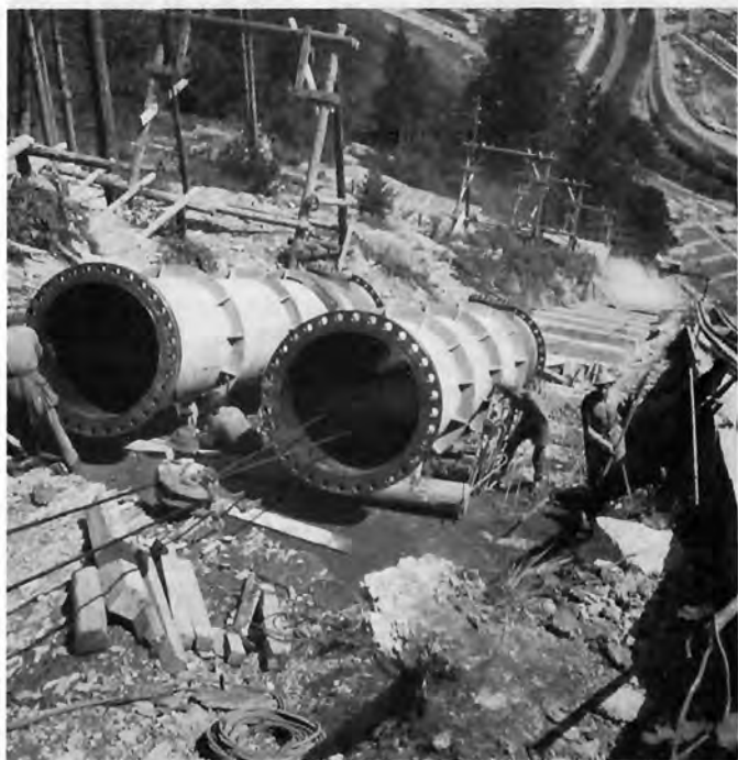
Bild 66: Montage der Festpunkt-Krümmen der Stränge III + IV der Druckrohrleitung der Hauptstufe Glockner-Kaprun. Krümmen mit angeschweißten Schubringen und Flanschen
