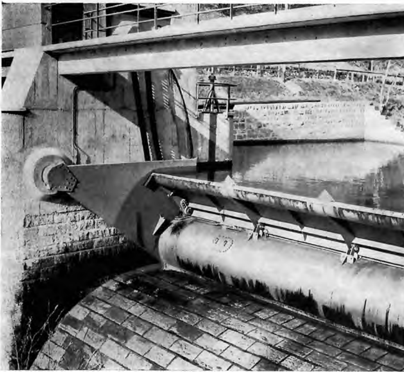
Bild 14: Sektor-Klappenschütze. Spülschütze des K.-W. Riddes. Wasserfassung Dranse. Gewicht \approx 5,5 t Max. Wasserdruck \approx 6,8 m Höhe \approx 3,4 m Lichte Weite \approx 1,5 m Hauptträger, Klappe und Seitenschilder je vollständig geschweißt. Mechanisch stark beanspruchte Flächen aus rostfreiem Stahl. Werkstoffaufnahme. Ansicht vom Ober- wasser mit gehobener Klappe. Baujahr 1955
