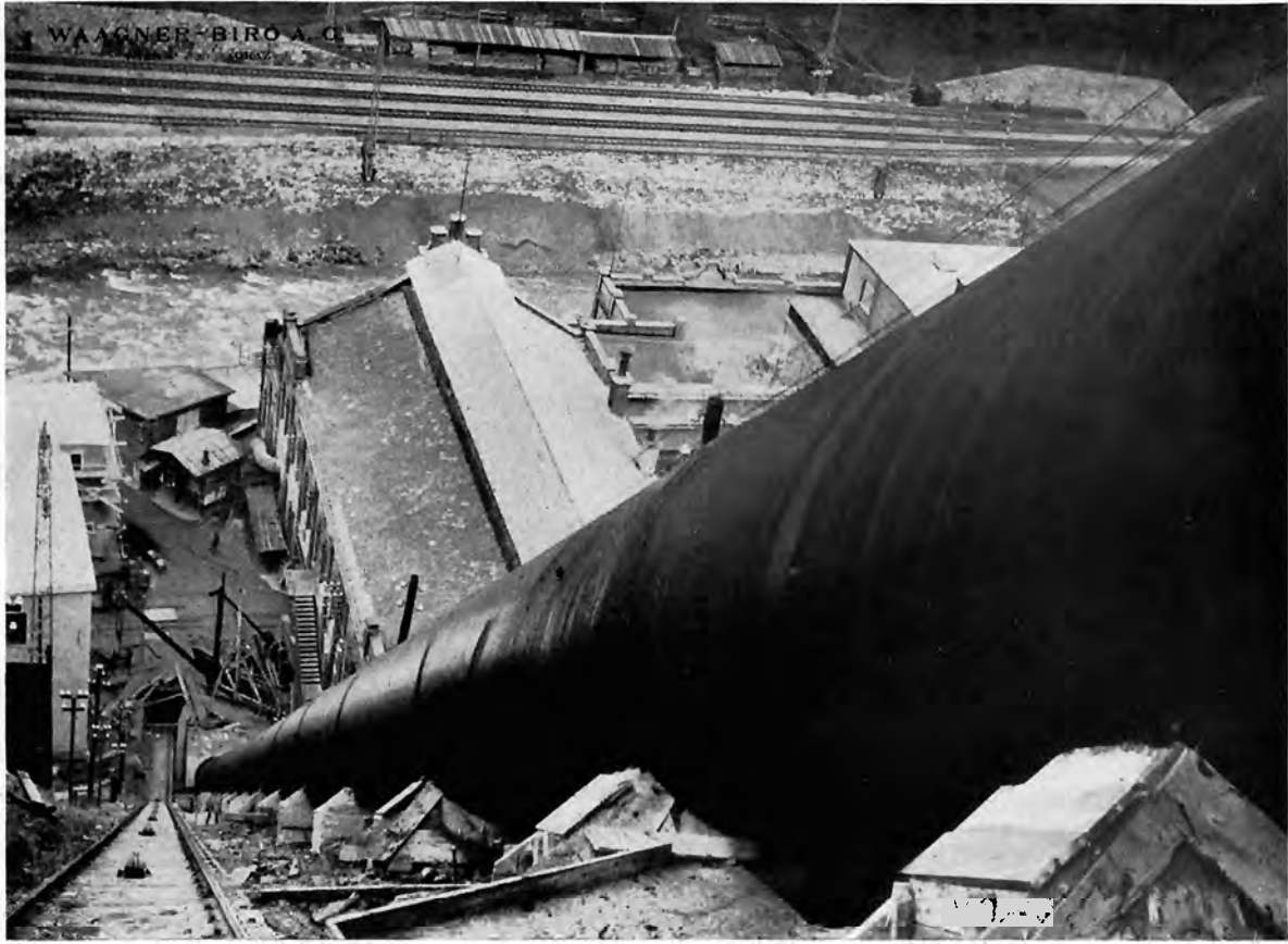
Bild 28: Druckrohrleitung Lend der Safzburger Aluminium-Gesellschaft. Erste vollkommen lichtbogen-geschweißte Druckrohrleitung Österreichs. Waagner-Biró AG, Wien-Graz
