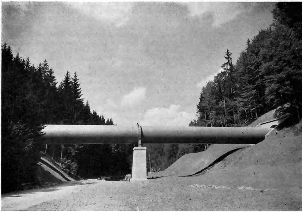
Bild 78: Rohrbrücke über den Genitzbach, Druckrohrleitung des Kraftwerkes Dobra-Krumau der NEWAG. VOEST-Linz
