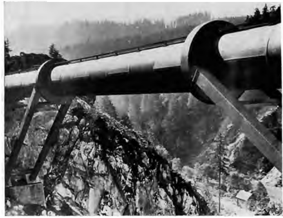
Bild 58: Rohrbrücke der Druckrohrleitung des Salzkraftwerkes. VOEST-Linz
