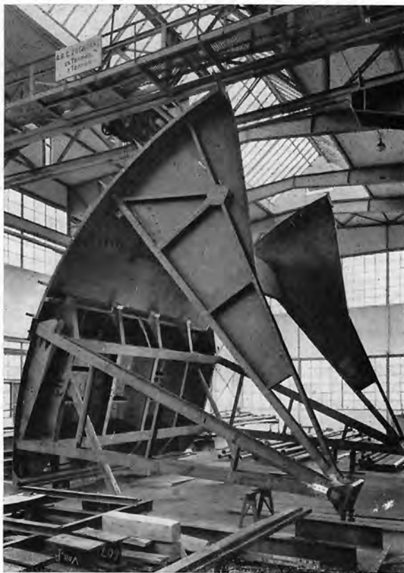
Bild 11: Sektor-Hakenschütze. Hochwasserentlastungsanlage der Staumauer Rossens. Werkstattaufnahme. Ansicht vom Unterwasser
