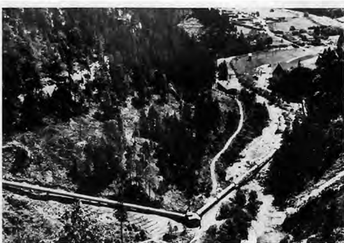
Bild 57: Druckrohrleitung des Salzkraftwerkes der STEWEAG. VOEST-Linz
