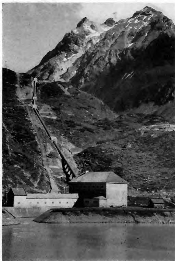
Bild 38: Untere Steilstrecke der Druckrohrleitung des Obervermuntwerkes der VIW. Krafthaus am Ufer des Vermuntstausees
