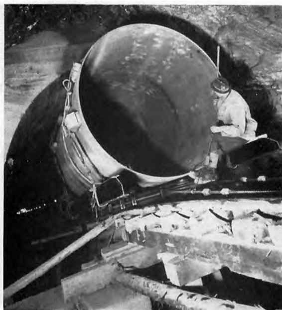
Bild 72: Rohrstollenleitung des Kraftwerkes Uttendorf (Stubach III) der Österr. Bundesbahnen; Montage. Vgl. auch Bild 17. Waagner-Biró AG, Wien-Graz
