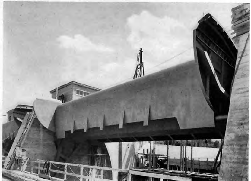
Bild 12: Sektor-Klappenschütze. K.-W. Wildegg-Brugg. Hauptwehr, 4 Öffnungen. Gewicht pro Öffnung = 63 t Höhe = 8,0 m Lichte Weite = 15,0 m Geschweißt mit Ausnahme der Montagestöße (Trapezförmiger Hauptträger in der Werkstätte vollkommen zusammenges- chweißt. Gew. = 21 t). Montageaufnahme. Ansicht vom Unterwasser in gehobener Stel- lung (Absolut glatter Überfall- rücken der Klappe).
