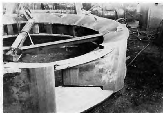
Bild 5: Turbinen-Traversenring „Jxtapantongo“ (Mexiko), vorbereitet zum Schweißen. J. M. Voith, St. Pölten
