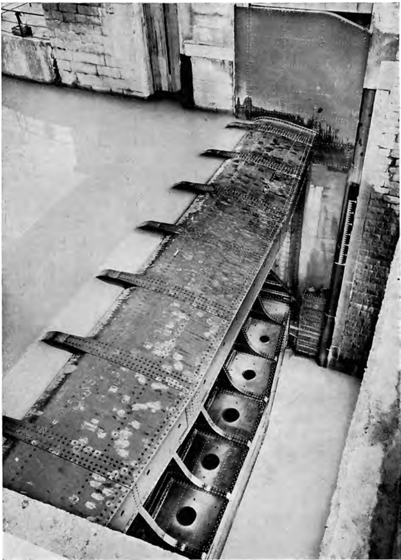
Blick von der Wehrbrücke auf die Wehranlage (Hakenscützen)
