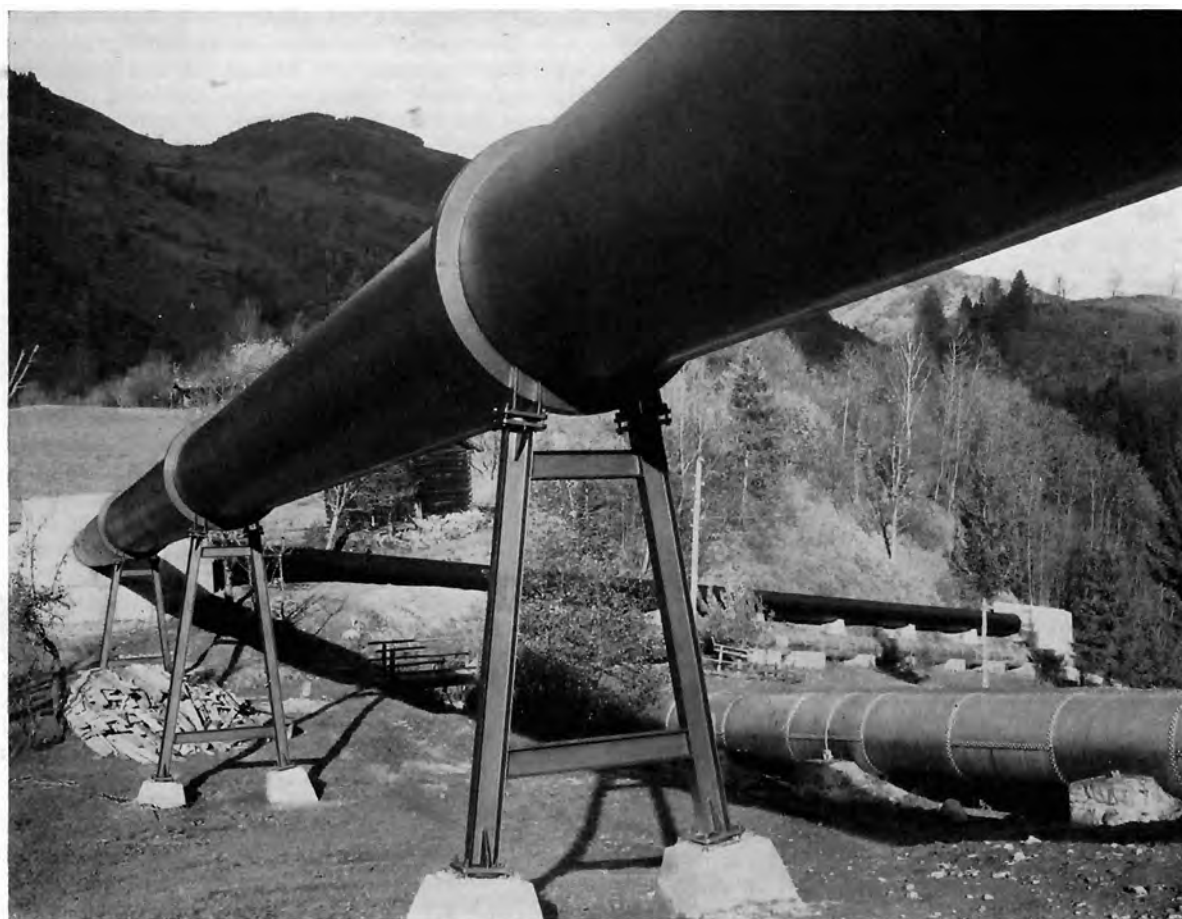
Bild 84: Druckrohrleitung des Kraftwerkes Rauris-Kitzloch der Salzburger Aluminium Gesellschaft. Wagner-Biró AG, Wien-Graz. Rechts der alte, genietete Strang
