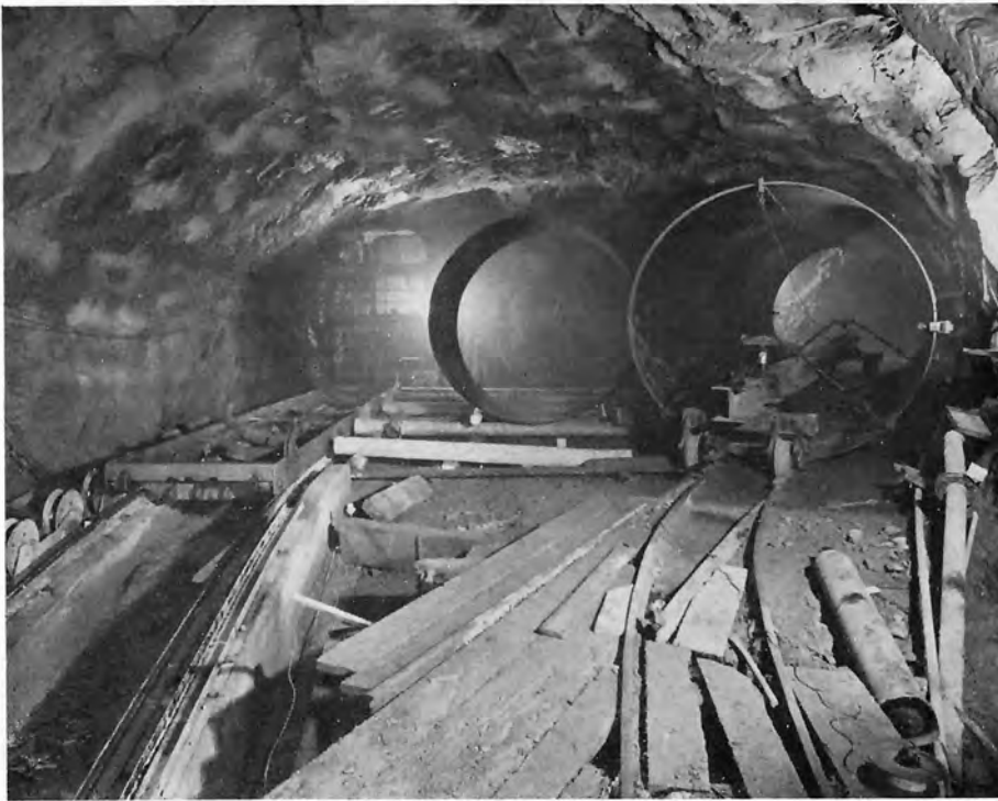
Bild 85: Druckschacht Limberg der Oberstufe Glockner-Kaprun der TKW. Zubringen der Panzerrohre am oberen Ende des Druckschachtes, links der Wagen zum Ablassen der Panzerrohre. Wagner-Biró AG, Wien-Graz
