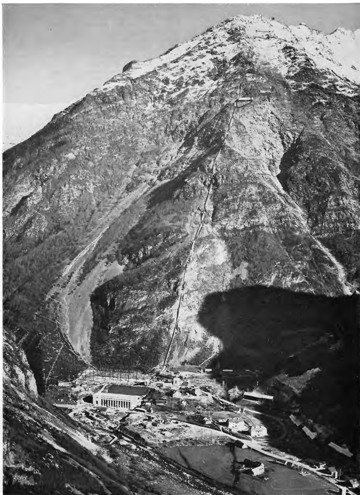
Bild 102: Druckrohrleitung Cap de Long des Kraftwerkes Pragnères (Hautes Pyrénées, Frankreich). S. D. E. M., Grenoble
