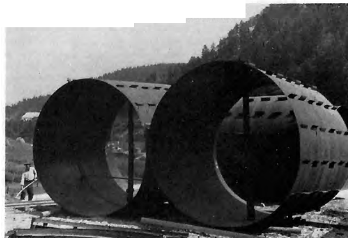
Bild 79: Panzerrohre mit Flachstahlankern gegen das Einbeulen durch den Gebirgswasserdruck. Druckschacht des Kraftwerkes Dobra-Krumau der NEWAG. Wagner-Biró AG, Wien-Graz
