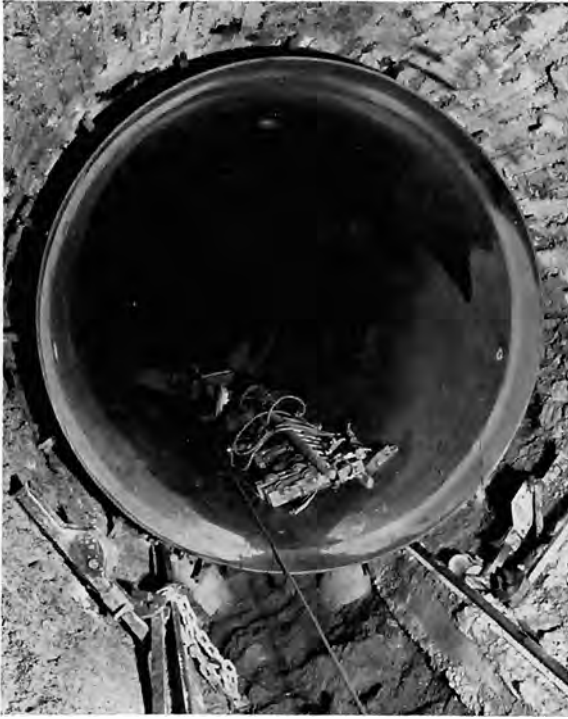
Bild 1: Schrägstollen-Panzerung Maiskogel, Falleitung der Hauptstufe Glockner-Kaprun der Tauernkraftwerke AG. Waagner-Biró AG, Wien-Graz
