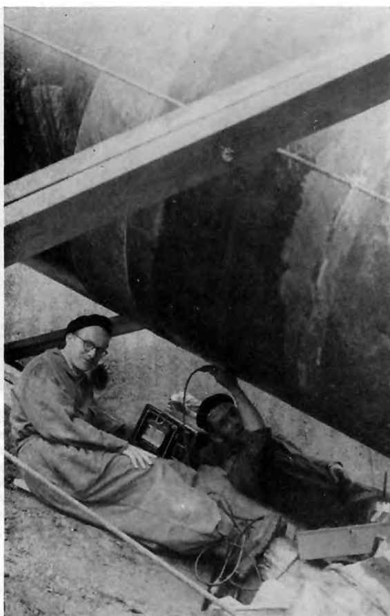
Bild 55: Ultraschallprüfung einer Montage-Rundnaht einer freien Druckrohrleitung. Druckrohrleitung Riddes (Anlage Mauvoisin, Walliser Alpen). Gebrüder Sulzer AG, Winterthur
