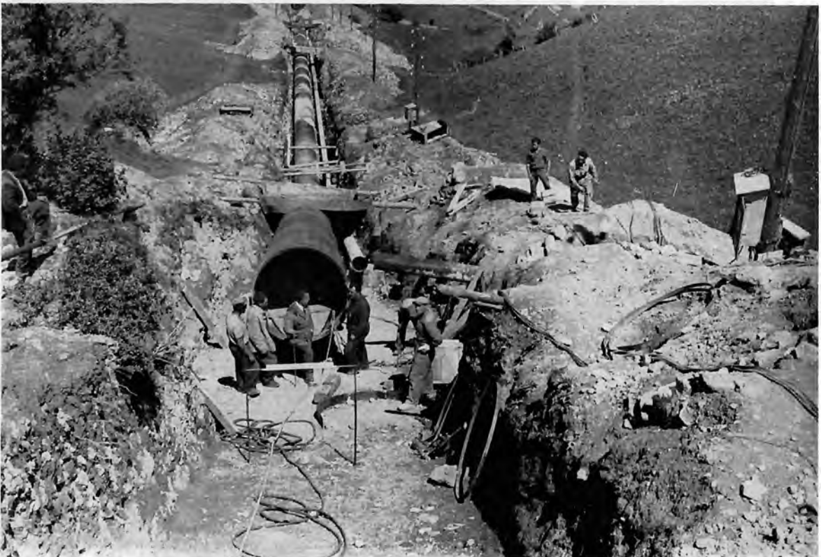
Bild 7: Eingeschüttete Druckrohrleitung während der Herstellung. Anlage Plima Lasa der Soc. Montecatini. Soc. TERNI, Terni
