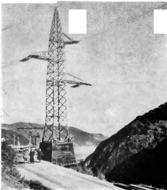
Bild 13: 110-kV-Leitung Kraftwerk Limberg — Umspannwerk Kaprun, Spezialabspannmast mit Hohlfundament Waagner-Biró AG, Wien-Graz
