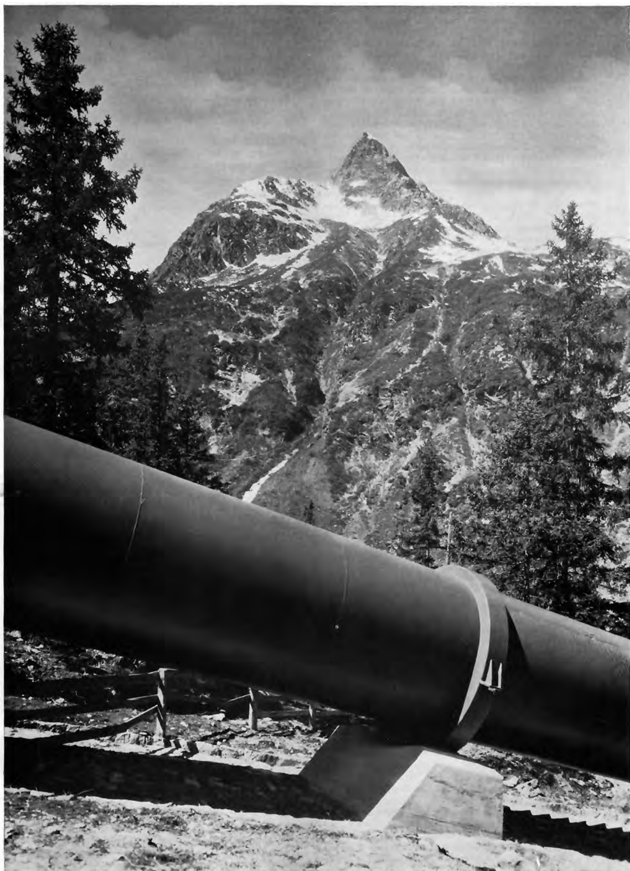
Bild 110: Eine österreichische Druckrohrleitung in der österreichischen Alpenlandschaft (Taldücker Kleinvermunt der VIW im obersten Paznauntal, Tirol)
