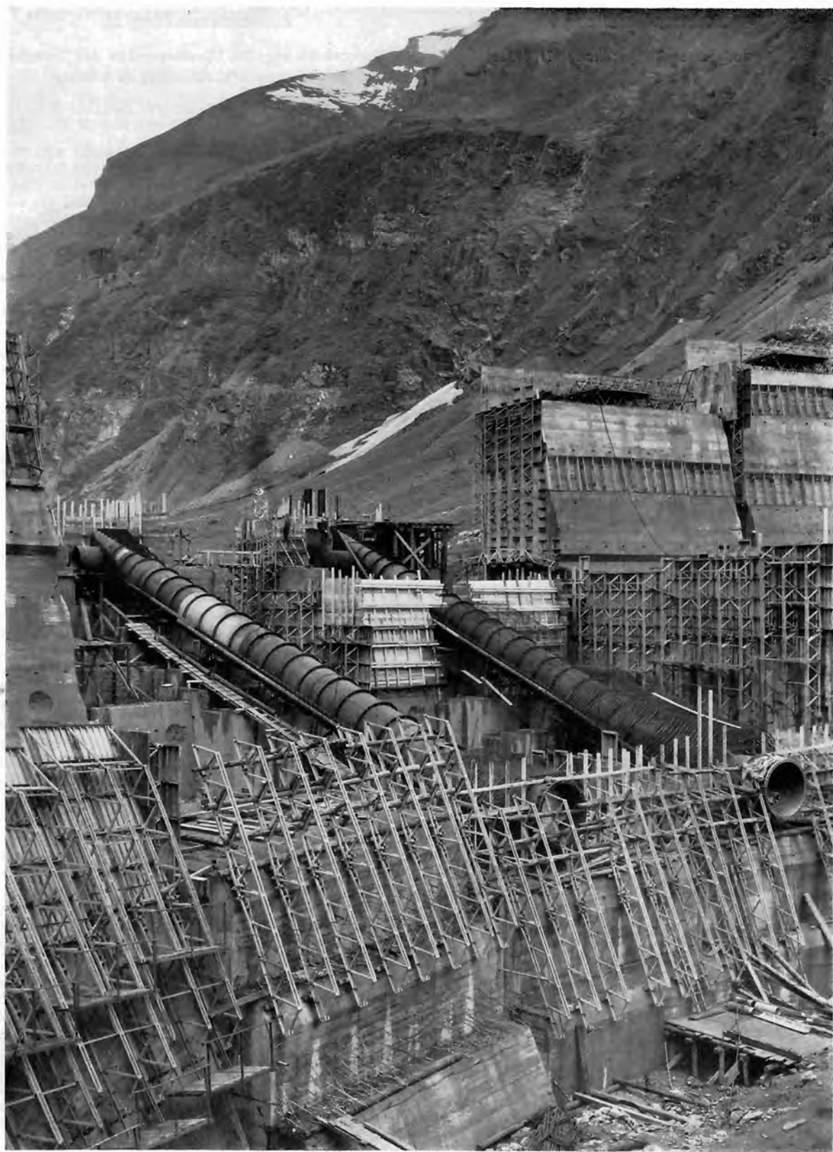
Bild 75: Durchführungsrohre durch den Sperrenkörper Limberg, Turbinenauslauf- und Pumpeneinlaufrohre der Oberstufe Glockner-Kaprun der TKW. Waagner-Biró AG, Wien-Graz. Im Vordergrund die Stahlschalungen für die Mauerblöcke der Gewölbemauer Limberg
