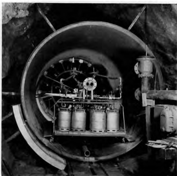
Bild 54: Spannungsfreiglühen der Montage-Rundnaht einer Druckstollen-Panzerung. Mit Butangas geheizter Innenglühofen. Blick auf die Stirnseite des neu angeschlossenen Panzerrohrstückes und auf den coaxialen Spalt zwischen dem Panzerrohr und dem Gebirge; dieser Spalt wird später ausbetoniert und hinterpreßt. Im Vordergrund die Butangasflaschen. Falleitung Fionnay der Anlage Grande Dixence (Walliser Alpen). Gebrüder Sulzer AG, Winterthur
