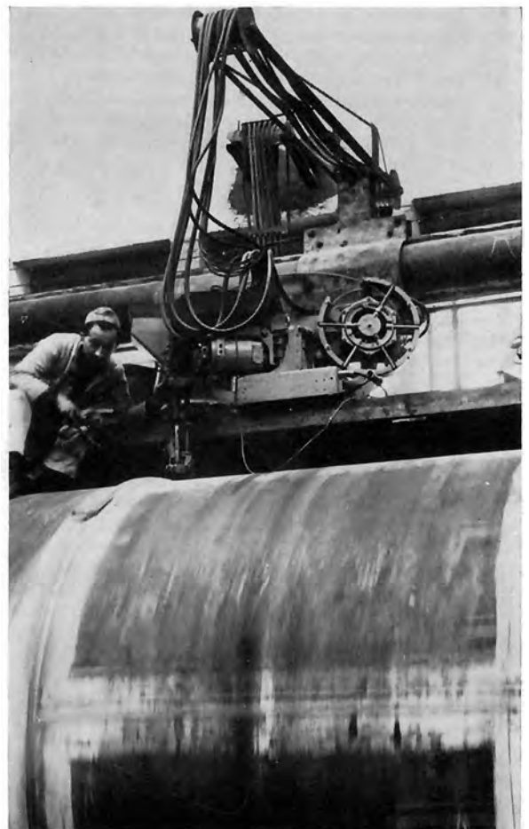
Bild 41: Automatschweißung einer Rundnaht. Soc. TERNI, Werk Terni
