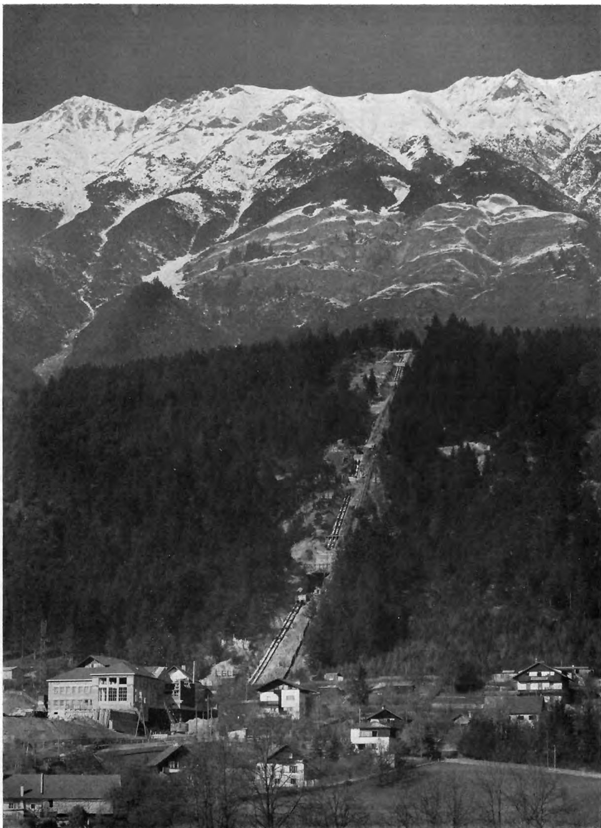
Bild 73: Druckrohrleitung des Kraftwerkes Mühlau der Trinkwasserversorgung der Stadt Innsbruck. Vgl. auch Bild 6. Waagner-Biró AG, Wien-Graz
