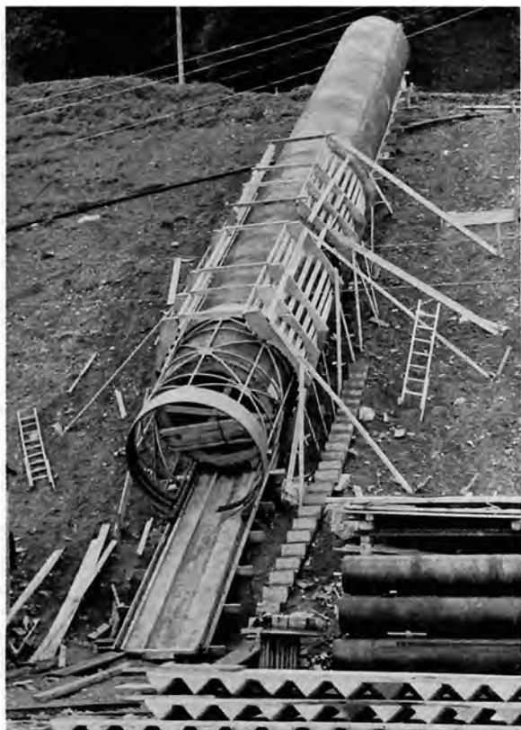
Bild 109: Röntgenfilmwagen zur Prüfung der Montage-rundnähte in der Steilstrecke des Druckschachtes des Lünserseewerkes. Rohrlänge 20 m, pneumatisches Anpressen der Filmkassette. Erprobung des Wagens an einem naturgroßen Holzmodell des Panzerrohres und der Schacht-Innenleibung. Dortmunder Union Brückenbau-AG, Werk Orange, Gelsenkirchen
