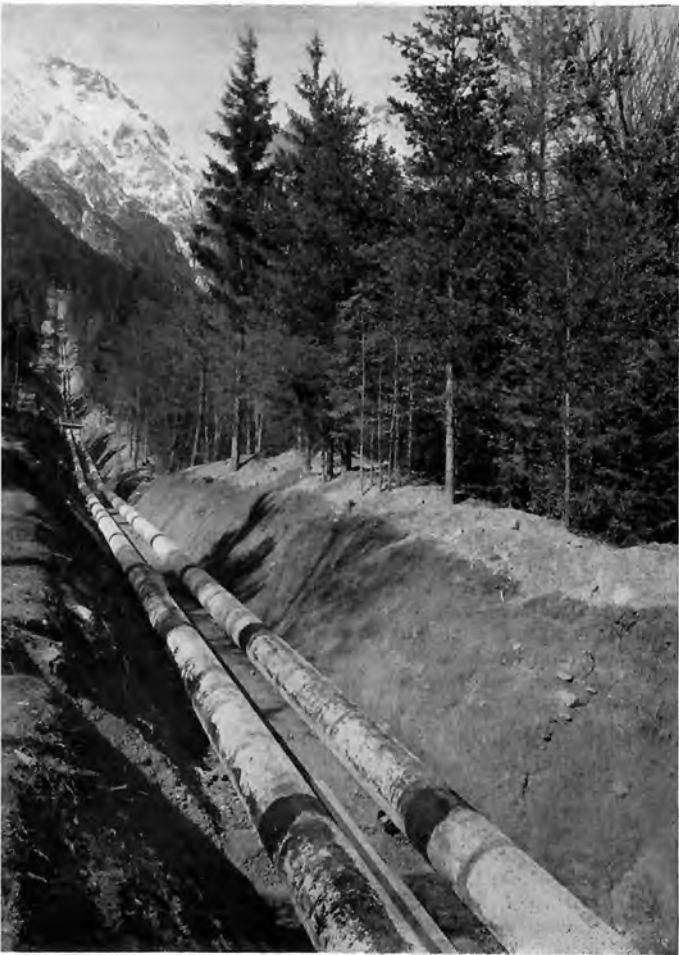
Bild 6: Eingeschüttete Druckrohrleitung während der Herstellung. Kraftwerk Mühlau der Stadt Innsbruck. Wagner-Biró AG, Wien-Graz
