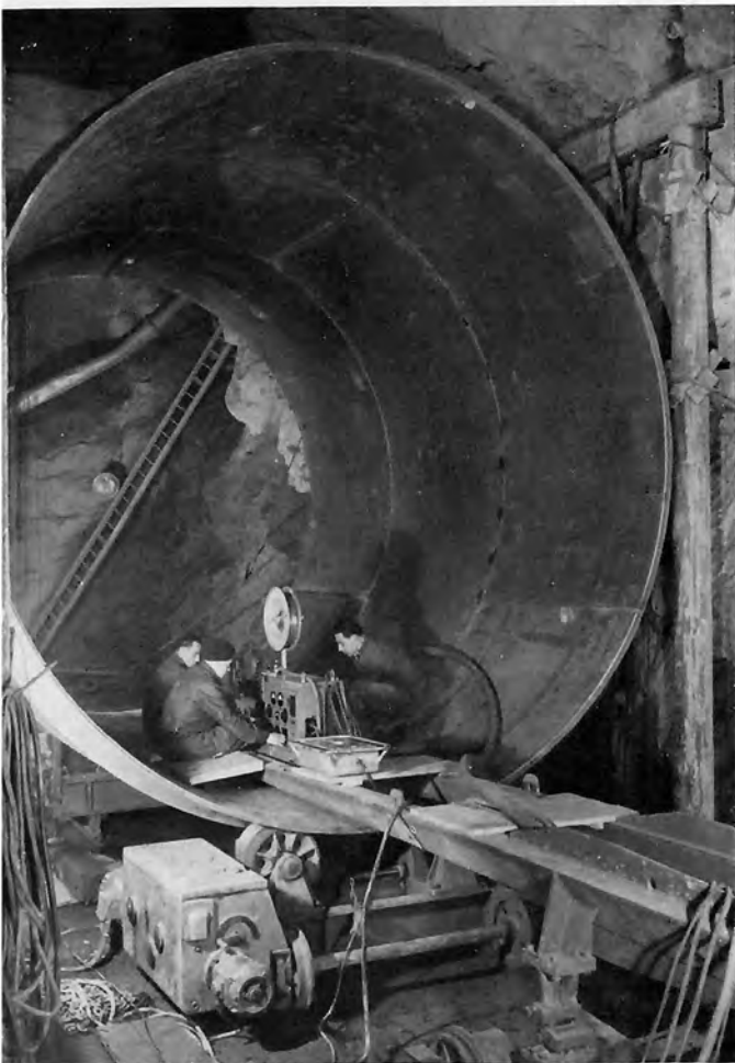
Bild 50: Elliraschweißung einer Wasserschloß-Panzerung von 5300 mm Durchmesser nahe der Einbaustelle. Falleitung Fionnay der Anlage Grande Dixence, Walliser Alpen. Gebrüder Sulzer AG, Winterthur
