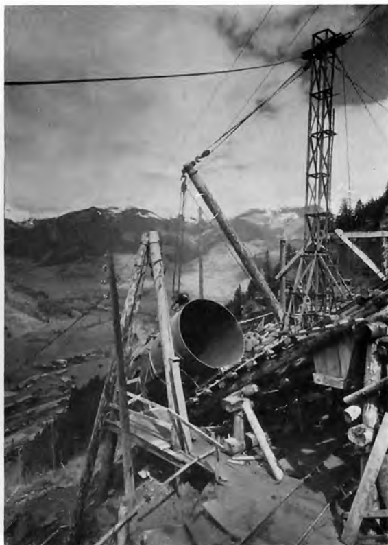
Bild 48: Druckrohrleitung des Kraftwerkes Uttendorf (Stubach III) der Österr. Bundesbahnen, Transport eines Rohrstückes zur Einbaustelle. Waagner-Biró AG, Wien-Graz
