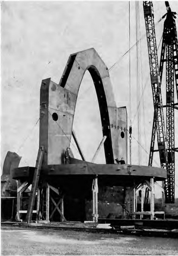
Bild 5: Hosenrohr 8000/2 \times 5940 mm Durchmesser für das Kraftwerk Sariyar im Werkszusammenbau
