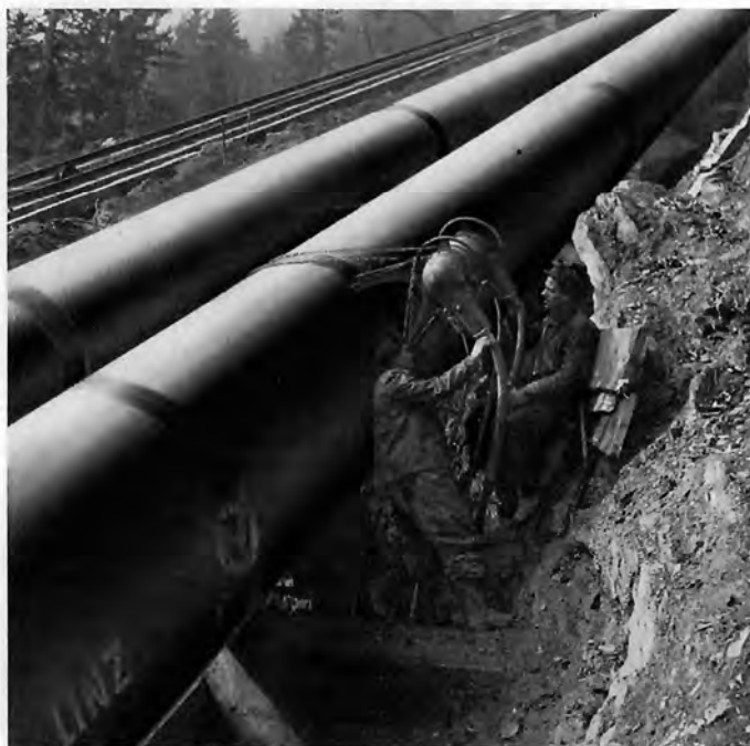
Bild 56: Röntgenprüfung der Montage-Rundnähte einer freien Druckrohrleitung. Druckrohrleitung III und IV der Hauptstufe Glockner-Kaprun
