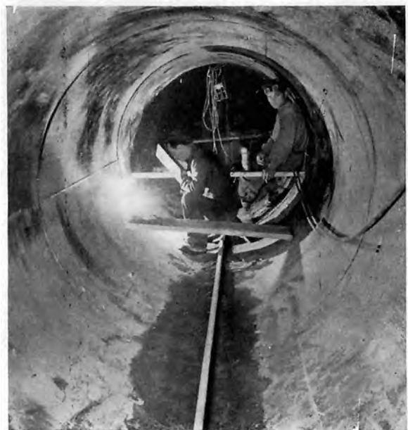
Bild 2: Druckstollen-Panzerung von 1800 mm Durchmesser, Lichtbogenschweißung einer Montage-Rundnaht. Soc. COFOR, Milano
