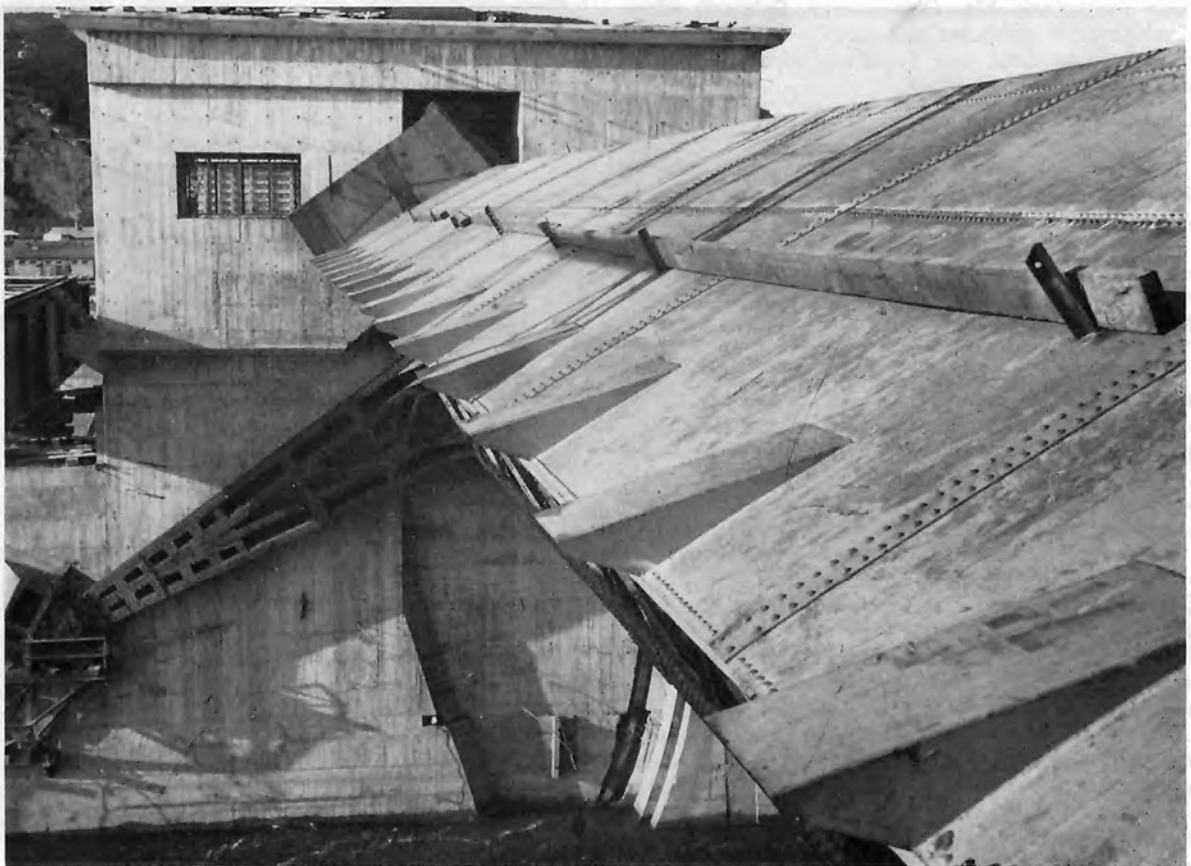
Bild 17: Aufsicht auf Klappe der Sektor-Hakenschützen des K.-W. Donzère-Mondragon (Strahlbrecher). Aufnahme während der Montage
