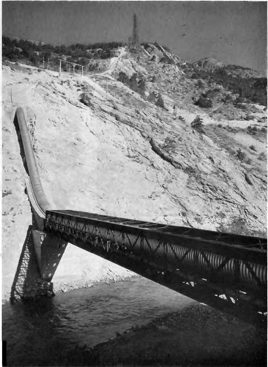
Bild 13: Fachwerkbrücke zur Überführung einer bandagierten Druckrohrleitung. Anlage Aussois, S. D. E. M., Grenoble
