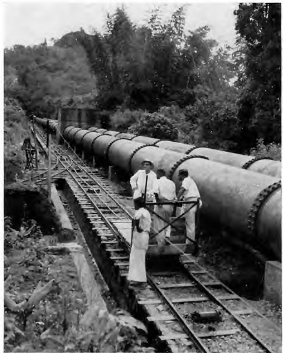
Bild 49: Lichtbogengeschweißte Druckrohrleitung mit genieteten Montagesößen. Anlage Sengulam in Südindien. Dortmunder Union Brückenbau-AG, Werk Orange, Gelsenkirchen
