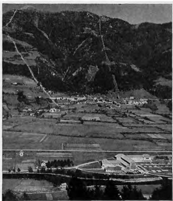
Titelbild: Blick auf die Druckrohrleitung Reifheck (Laufwerksleitung und Trasse der Speicherstufenleitung, beides links im Bild) mit Überführung der Tauernbahn-Südrampe. Blick auf den Talgrund (eingeschüttete Druckrohrleitung unsichtbar) und auf das Krafthaus Kolbnitz am Ufer der Möll.
