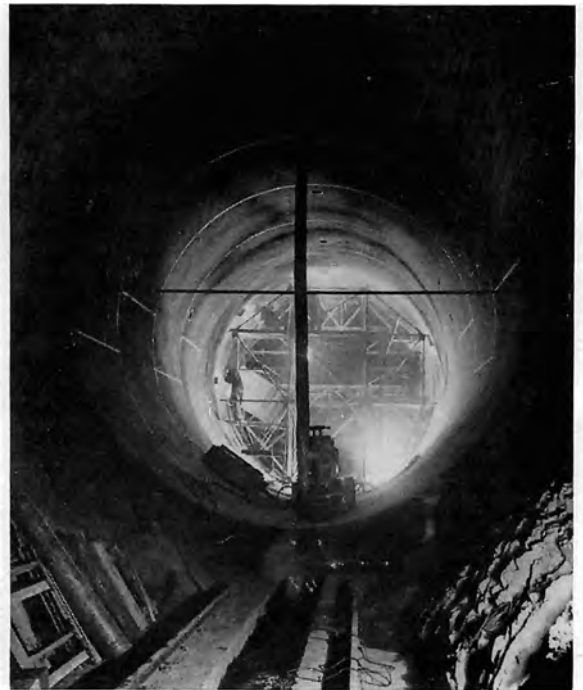
Bild 52: Schweißung der Montagerundnähte von innen. Panzerrohre mit D_i = 6000 mm, s = 14/36 mm, nahe der Einbaustelle aus Teilschalen hergestellt. Rheintalstollen Schluchsee III (Waldshut). Baustahl St 52 Feinkorn. Dortmunder Union Brückenbau-AG, Werk Orange, Gelsenkirchen
