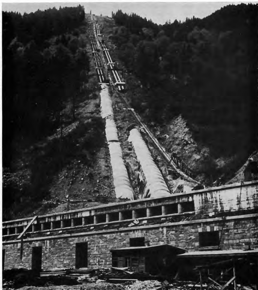
Bild 63: Druckrohrleitung der Hauptstufe Glockner-Kaprun der TKW. Links die beiden Stränge I + II; rechts die beiden Stränge III + IV im Bau. Im Vordergrund das Krafthaus, dahinter der eingedeckte untere Teil der Druckrohrleitungen I + II und III + IV
