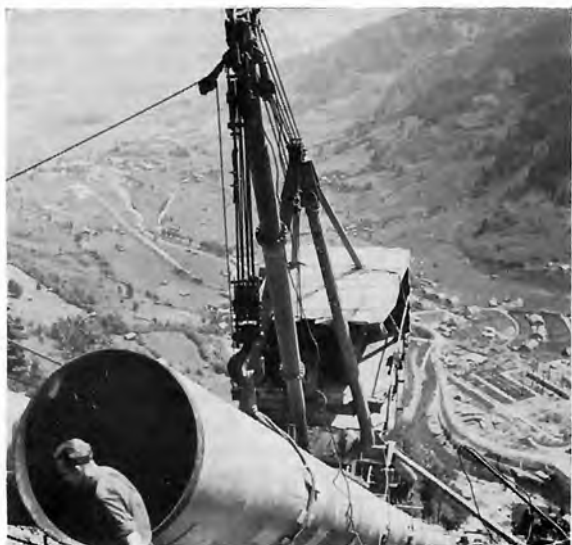
Bild 65: Montage der Stränge III + IV der Druckrohrleitung der Hauptstufe Glockner-Kaprun; Reiterkran. VOEST-Linz. Im Talgrund rechts die Freiluftschaltanlage, im Talgrund links der Ort Kaprun
