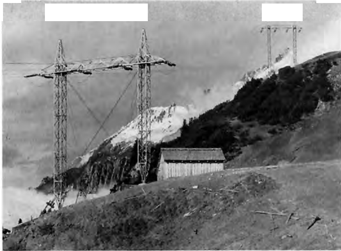
Bild 6: 110-kV-Leitung Zirl — Spullerseewerk Waagner-Biro AG, Wien-Graz
