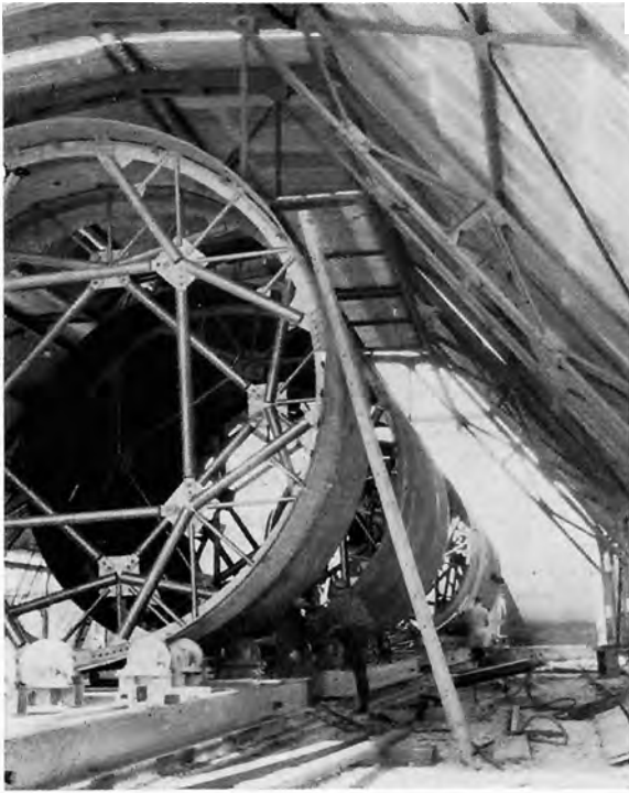
Bild 51: Herstellung der Rohre aus Teilschalen nahe der Einbaustelle. Schweißzelle mit elektrisch betriebenen Rollgängen; Automat-Schweißung; Aussteifungsgerüste für die großen Rohre. Schluchsee II (Witznau), Meltmastollen, D_i = 4800 mm, s = 20/22 mm, Stahl UNION 36. Dortmunder Union Brückenbau-AG, Werk Orange, Gelsenkirchen
