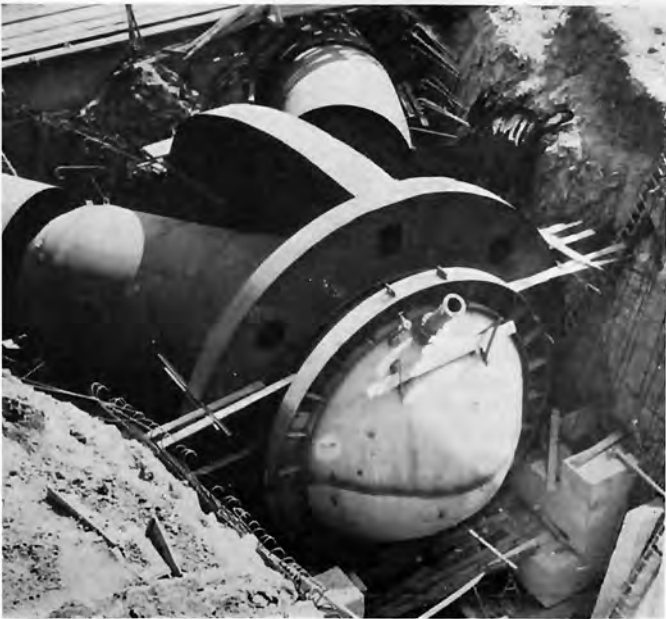
Bild 6: Baustellendruckprobe eines 6-m-Hosenrohres für das Kraftwerk Sariyar
