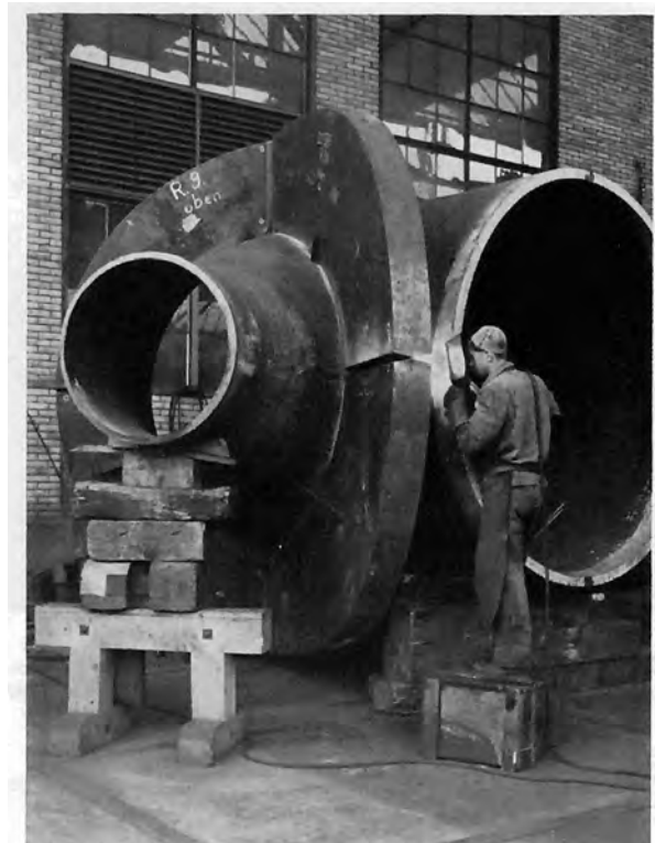
Bild 101: Viertes (im vorübergehenden Bauzustand letztes) Abzweigstück der Verteilrohrleitung des Kraftwerkes Fionnay, Grande Dixence, Walliser Alpen. Schweißen des 200 mm dicken Kragens aus ALDUR 58, schmale Tulpennäht. Das Hauptrohr mit D_i = 2430 mm und s = 58 mm (gleichfalls aus ALDUR 58) wird provisorisch verschlossen. Gebrüder Sulzer AG, Winterthur
