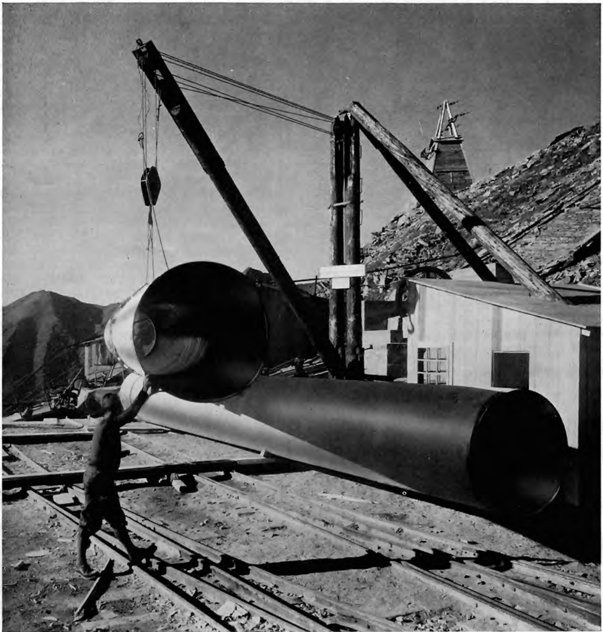
Stollenrohre zum Einbau am Schoberboden (Draukraftwerk Reifheck).
