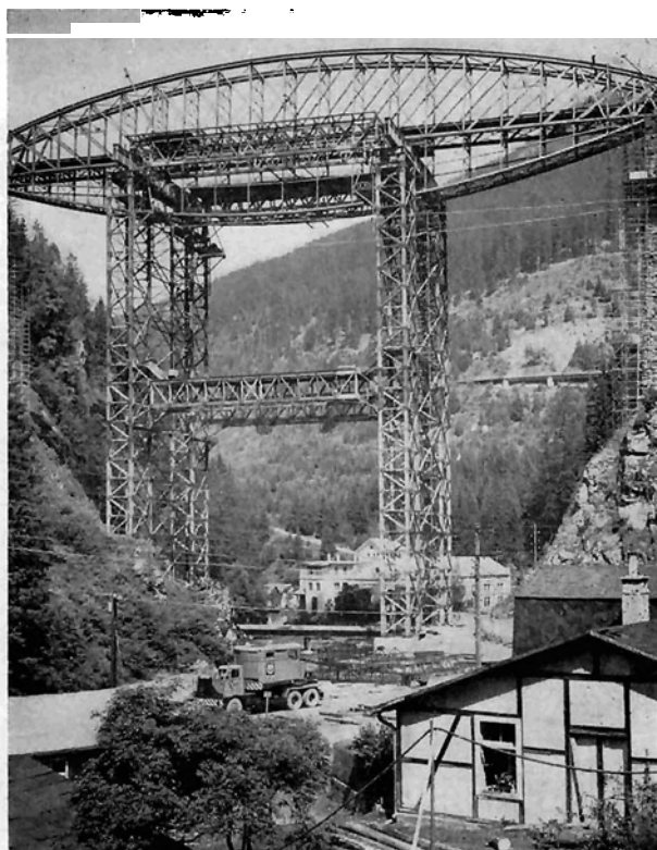
Bild 8: Montage der Stiele B und D mit Kletterderricks Fig. 8: Installation of the legs B and D by erecting derricks
