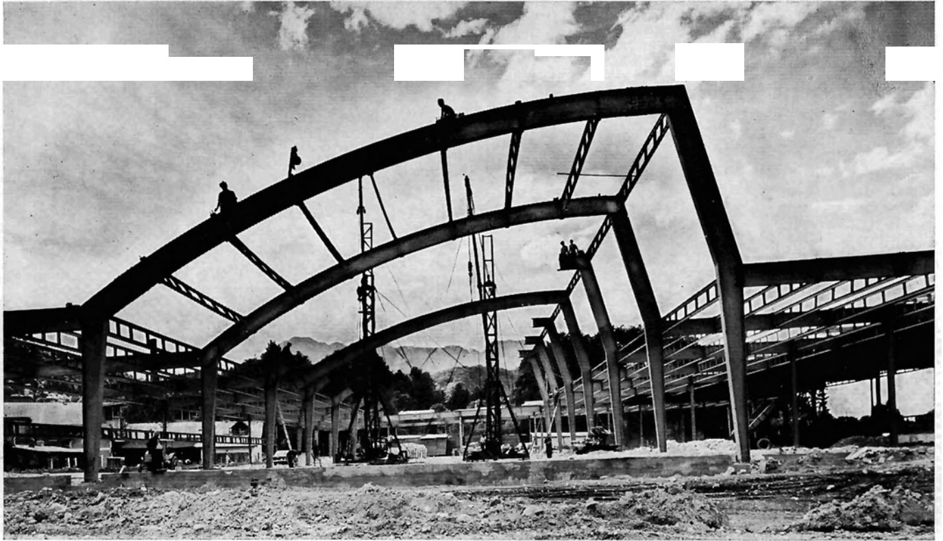
GESCHWEISSTE HALLENKONSTRUKTIONEN FÜR EINE PAPIERFABRIK IN ÖSTERREICH
