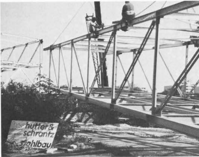
Montage eines Brückenschusses
