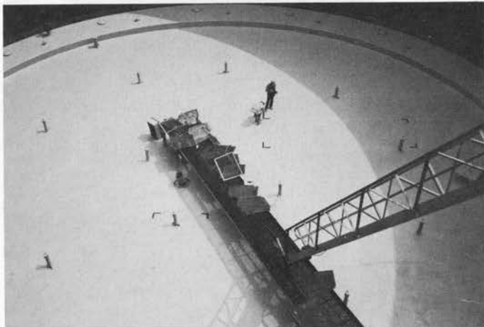
Schwimmdachbeschichtung; ÖMV Schwechat
